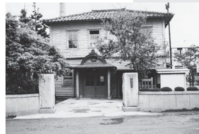
かろうじて火事をまぬかれた旧事務所棟
