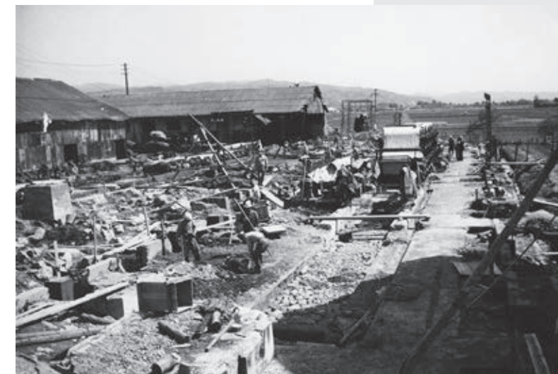
一部の建物を残し、ほとんどの施設が灰となった
