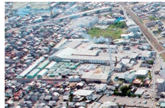
2008(平成20)年撮影の当社航空写真。まだ北陸新幹線の工事は始まっておらず、右手に北陸線だけが通っている
