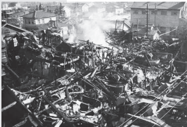
鎮火間もない工場敷地
