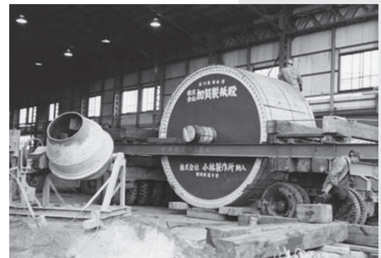
3号機に備え付けられるヤンキードライヤー。側面には「加賀製紙」「小林製作所納入」の文字が見える
