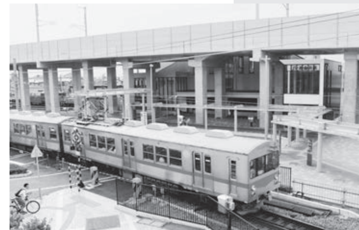
現在の北陸鉄道石川線。線路の向こう側はJR北陸線西金沢駅
