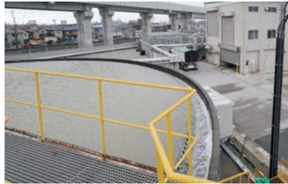
クラリファイヤーと呼ばれる凝集沈殿池。ここで微細な繊維を沈殿させて取り出す
