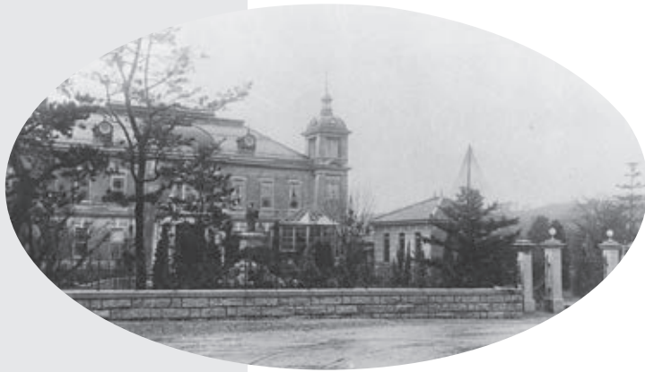
金沢市内にあった横山鉱業部の建物
