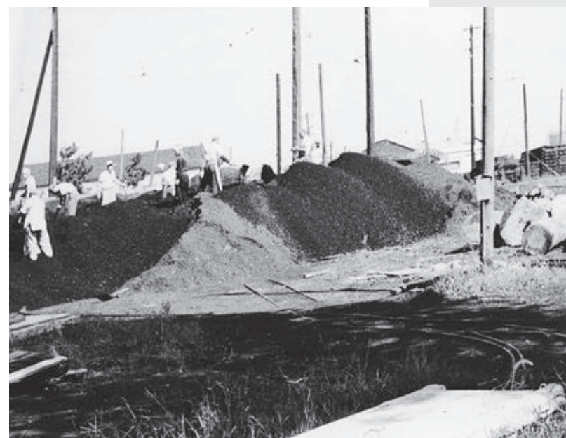
工場敷地内に積まれた石炭。主に蒸気の発生用に使われた=昭和 20 年代撮影
