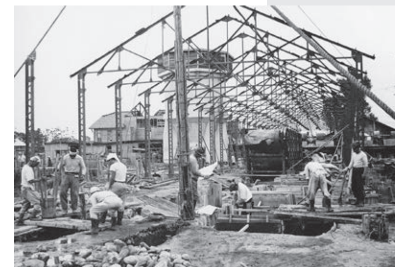
抄紙機の建屋の再建に励む社員ら。1日も早い操業のため火災前の仕様とした
