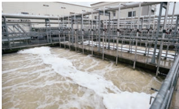
有機物を分解する微生物を活性化させるため、空気を送り込んでいる
