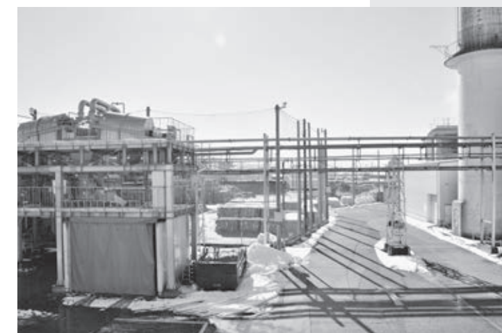
左側の建物で製紙カスを圧縮・脱水。その後、外部で処理を行った上で右のRPFボイラーで燃焼処理される
